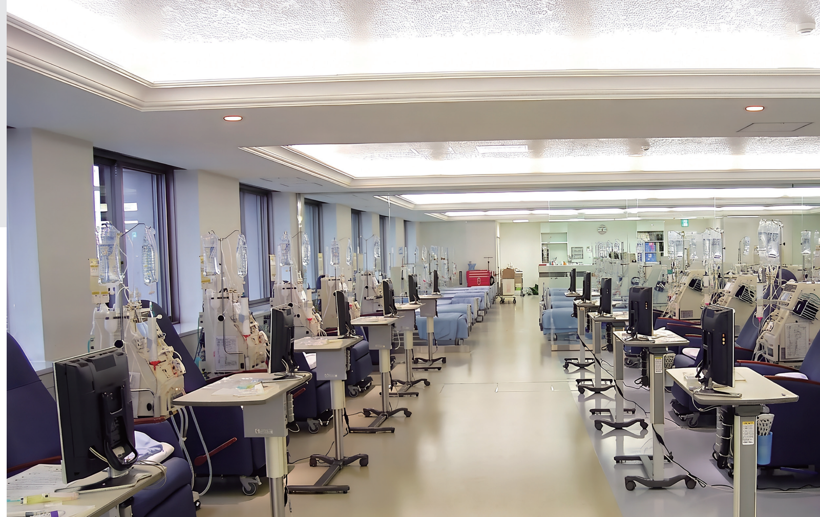
特定医療法人 桃仁会病院 透析室 2005年竣工
