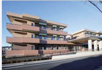
千葉県 2015 年竣工
