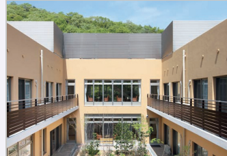
兵庫県 2016 年竣工
