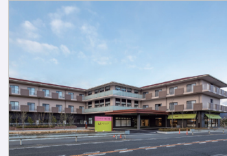
兵庫県 2020 年竣工
