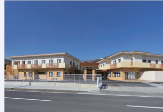
兵庫県 2014 年竣工
