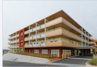
兵庫県 2019 年竣工
