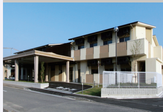
兵庫県 2011 年竣工
