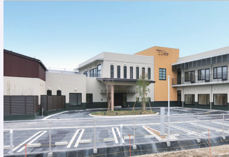
兵庫県 2014 年竣工
