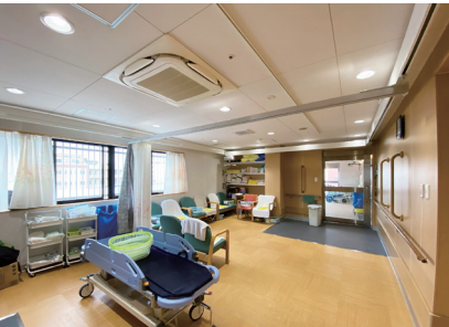
淳風とよなか 脱衣室改修
