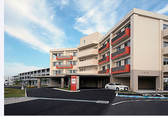
千葉県 2021 年竣工
