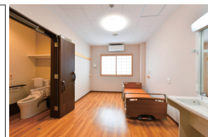
居室室内トイレ トイレの奥行方向が開く大開口ドア施工例
