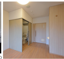
2方向に開く居室内トイレ
