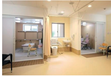
2ユニットで異なる種類の浴室 (介護用UB・ユニバス)を設置した事例
