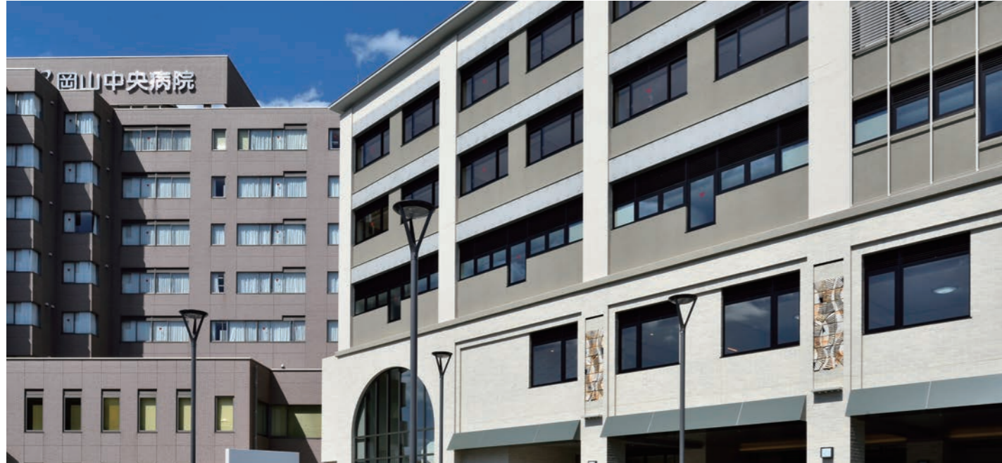
左/既存病院 右/今回増築した東館
