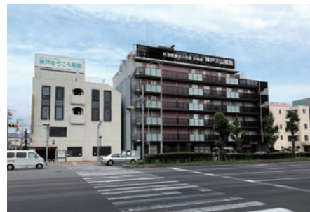
1期工事完了時外観。左側が既存病院建物。既存病院を解体し、2期工事として1期部分に増築する。
