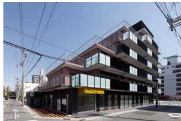
北西からの外観。法規制により上階に行くにつれ建物がセットバックしている。
