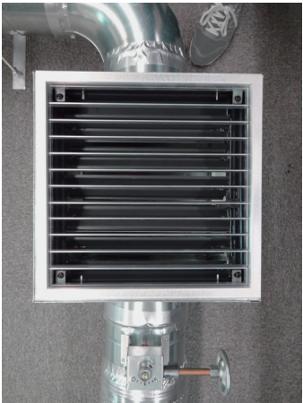
(左) 水平気流用吹出口（既製品）市場に流通する資材を組み合わせることで、コストを抑える。
