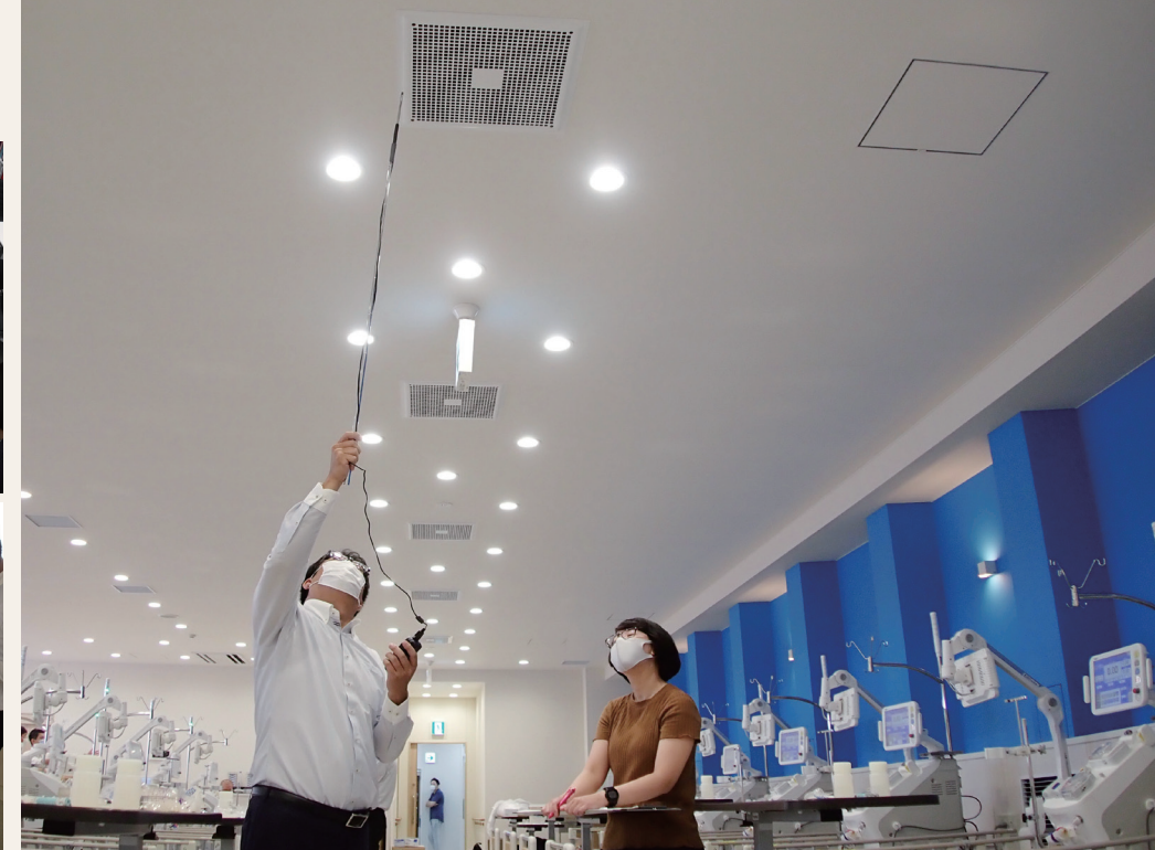
いんざいさくらクリニック 風量・風速測定
