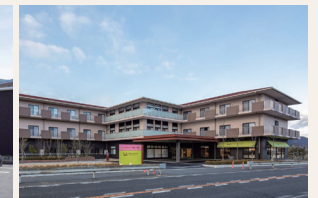
ハートコート桜丘3号館 兵庫県
