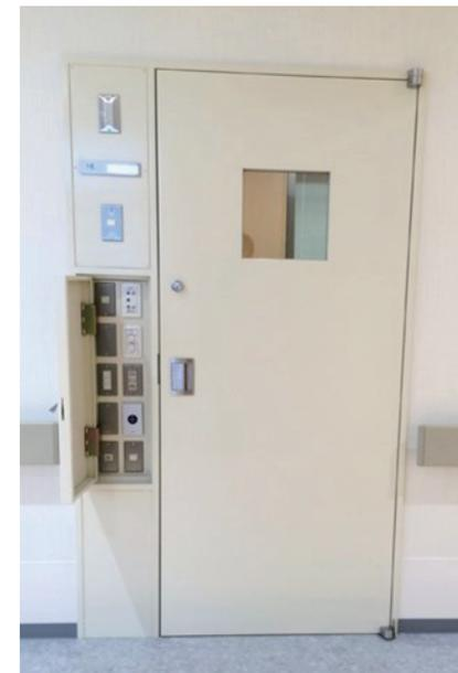
照明等のスイッチを誤操作を防ぐために保護室出入口脇の小扉の中に納め、保護室内の状況を確認しながら操作可能
