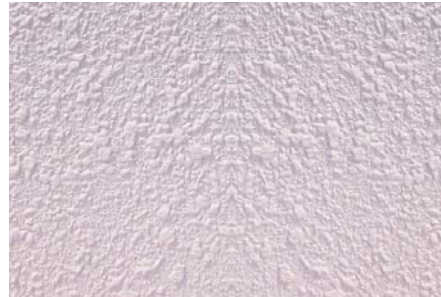
吹き付けタイル
