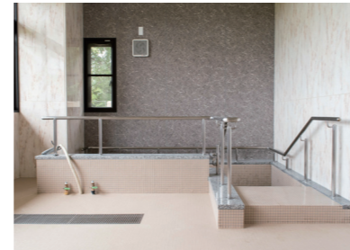
改修後の浴室
