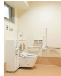
改修後の車椅子トイレ
