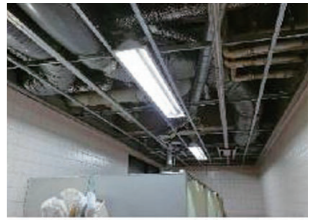
下階の上階排水管工事
