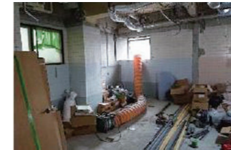
上階のトイレ改修工事
