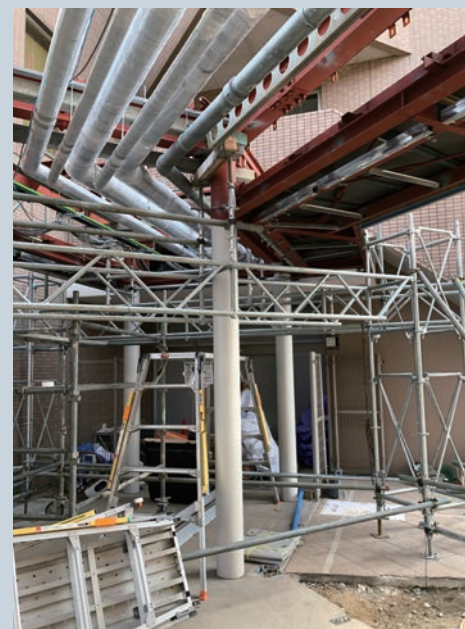
西館～本館の渡り廊下建替工事。衛生などの配管が何本も通っている。白い柱と赤い鉄骨は今回新設。長い杭が打てないため1mごとに溶接を行いながら施工した
