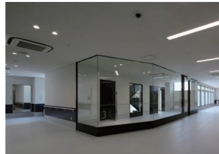
ガラススクリーンで仕切られた EVホール
