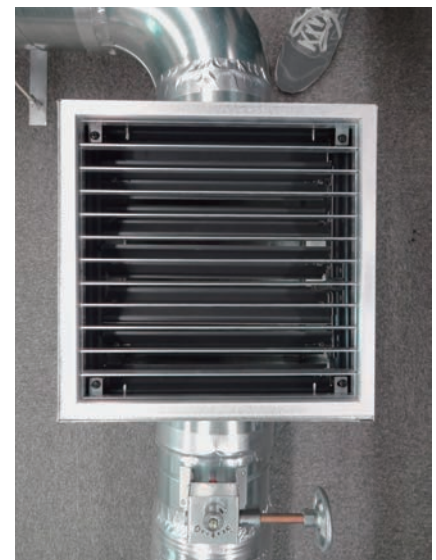
风量調節用吸込口 (ボリュームダンパー付) 場所によって偏りのあった吸込口の風速を均一化するために新たに導入しました。
