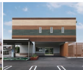
竹沢内科歯科医院 (透析ベッド30床) (三重県伊賀市)
