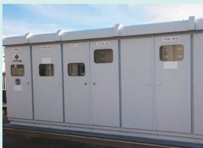
受変電設備 (キュービクル)
