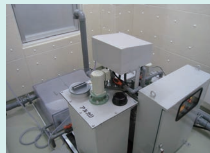
中和装置 (テナント内設置)
