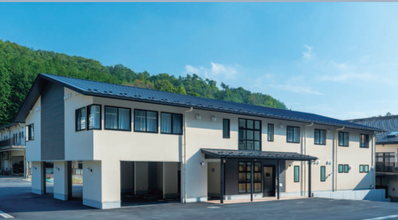
建替後の管理棟。エントランスホールにはこころみ学園の歩みが感じられる創立当時の写真が飾られている
