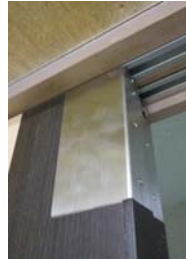
①吊り金物外れ防止補強
