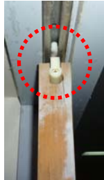
①吊り金物外れ防止補強
