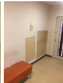
小さな力でも繰り返すことにより壁が破損した事例
