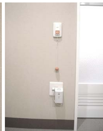
浴室のコンセントコール
