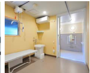
④菜の花ホーム 天井走行リフト
