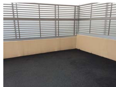
パラペット上のフェンス
