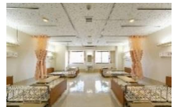
【壁掛けエアコンを設置】
