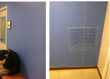
表面にメラミン化粧板を貼って改修するも一部破損
