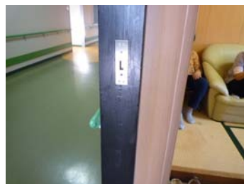
③枠側鍵補強
