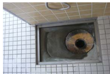
ホッパー失便装置1号 流水実験 (あまだ翠光園)
