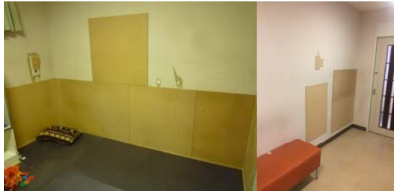
小さな力でも繰り返すことにより壁が破損した事例
