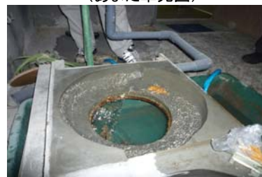
ホッパー失便装置2号 流水実験 (あまだ翠光園)
