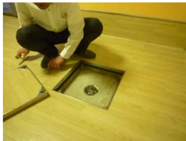
蓋付き排水設備
