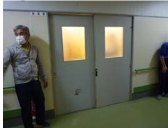
改修前の建具
