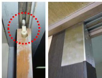
①吊り金物外れ防止補強
