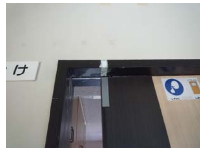
一旦ラインを合わせてから扉を閉める
