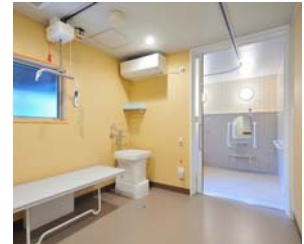
④菜の花ホーム 天井走行リフト
