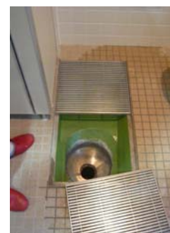
ホッパー失便装置1号機内部
