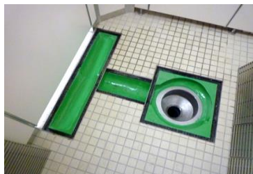
ホッパー失便装置2号機内部
