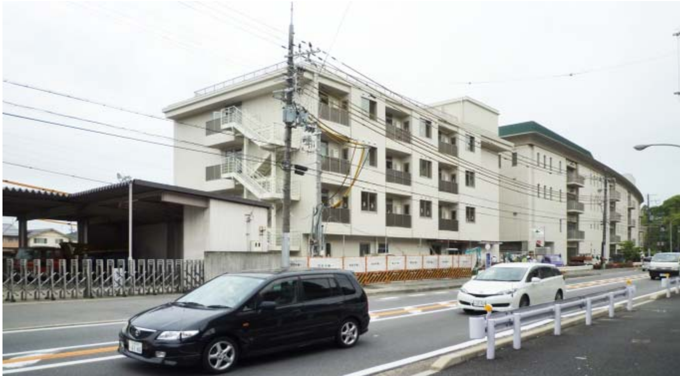
現在工事中の写真
