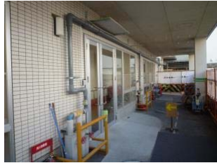
汚水の仮設配管、 仮設出入口。
