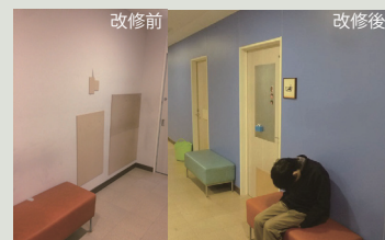
利用者の反復運動により剥がれた壁の改修を居ながら改修で行った事例
