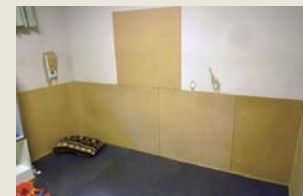
主に腰から下の部分の壁が破損したMDFボードによる簡易補修
