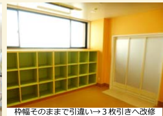
枠幅そのまま引違い→3枚引きへ改修
