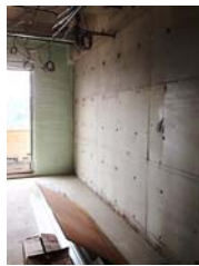
居室外壁沿い断熱+ボード
