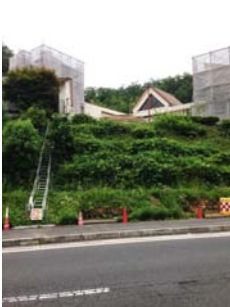
建物を通らない搬入ルート
