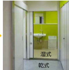
乾式（長尺塩ビシート） +湿式（塗床）の組合せ
