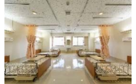
【壁掛けエアコンを設置】
