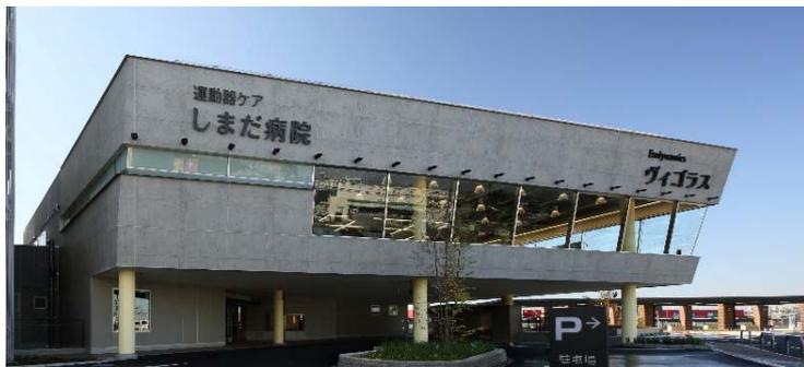
建築概要 鉄骨造 地下1階・地上6階 延床面積：11926.69㎡（1床あたり面積：約135.53㎡）
