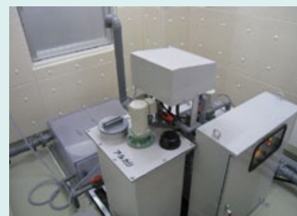
中和装置 (テナント内設置)
