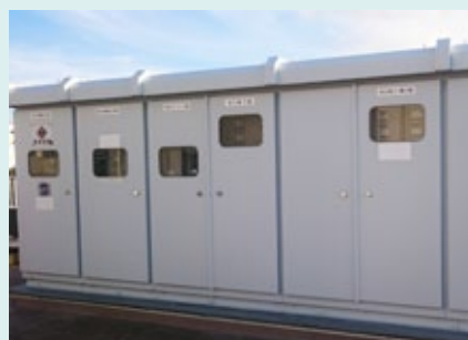
受変電設備 (キュービクル)
