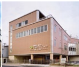
大道クリニック (透析ベッド77床) (大阪府八尾市)
