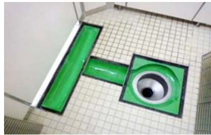
流水実験を重ねて開発した失便処理装置
