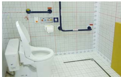
利用者の状態に合わせた手すりの配置
