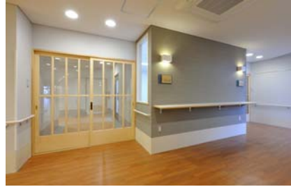
利用者の状況を調査し、必要な箇所に絞って手すりを計画した例
