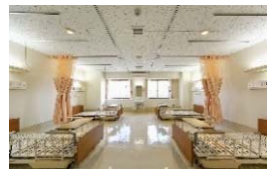
【壁掛けエアコンを設置】
