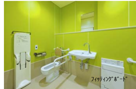
多目的トイレ+失便処理装置のブース
