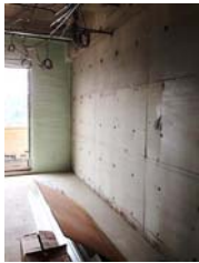
居室外壁沿い断熱+ボード
