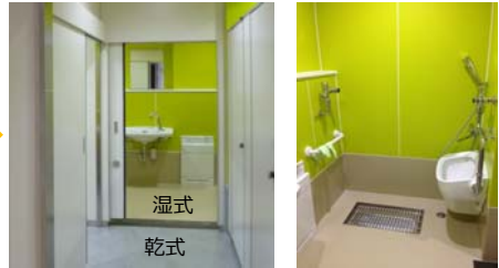
乾式（長尺塩ビシート）+湿式（塗床）の組合せ
